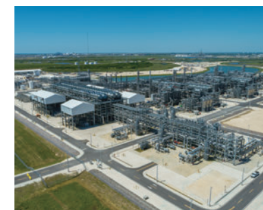
Freeport LNG Terminal in USA Courtesy of Freeport LNG Development, L.P.
